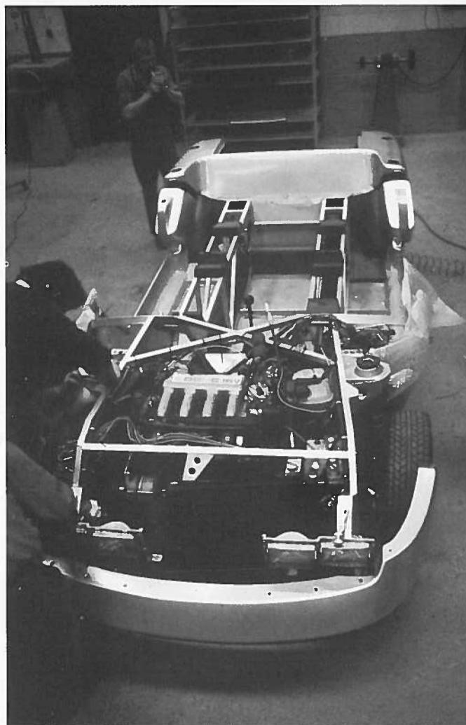
L'allestimento del prototipo Machimoto nel laboratorio dell'Ital Design. Il telaio è tubolare secondo una concezione tecnica che si riconferma alla Capsula del 1982.
